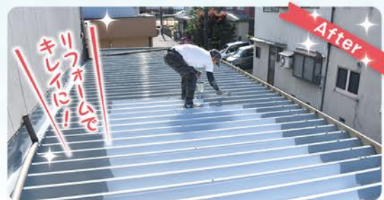
サビをきれいに落とした後は、再発を防ぐためにサビ止めを塗ってから、塗装を行いました。
